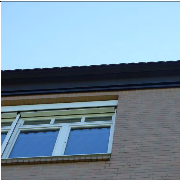
Abb. 4: Rollladenkästen an Krankenhausfenstern.
