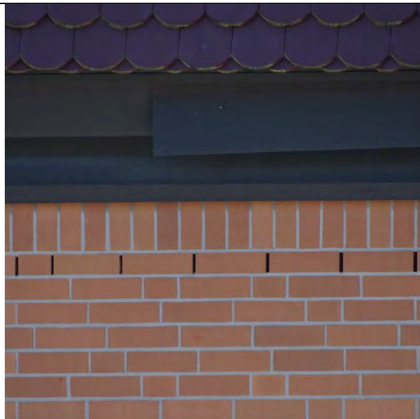
Abb. 5: Mauerwerksspalten als mögliche Fledermausquartiere.
