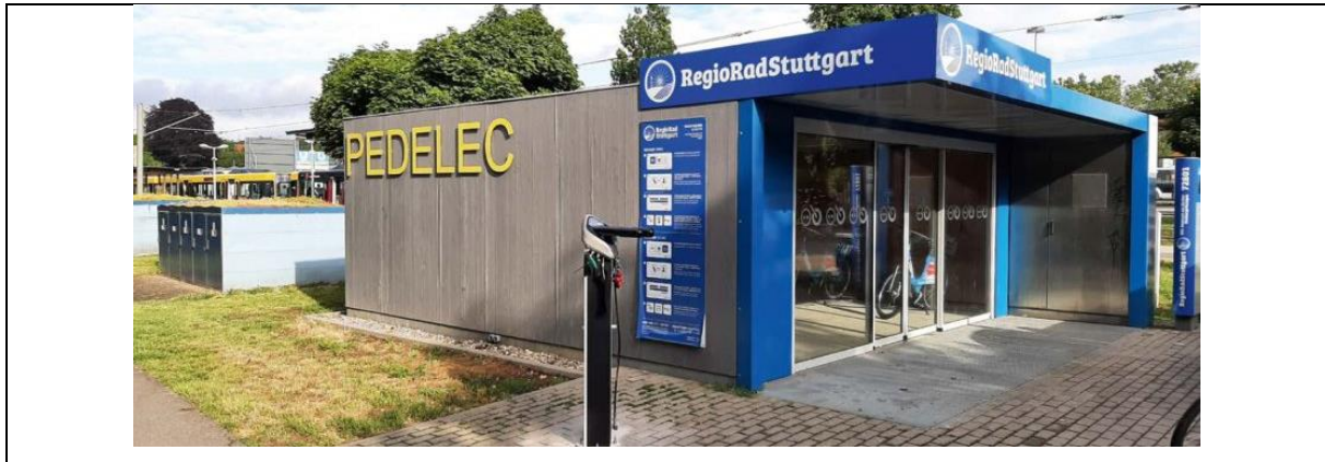
Abbildung 6: Radstation in Remseck am Neckar mit Reparaturstation (Quelle https://www.neckartalradweg-bw.de )
