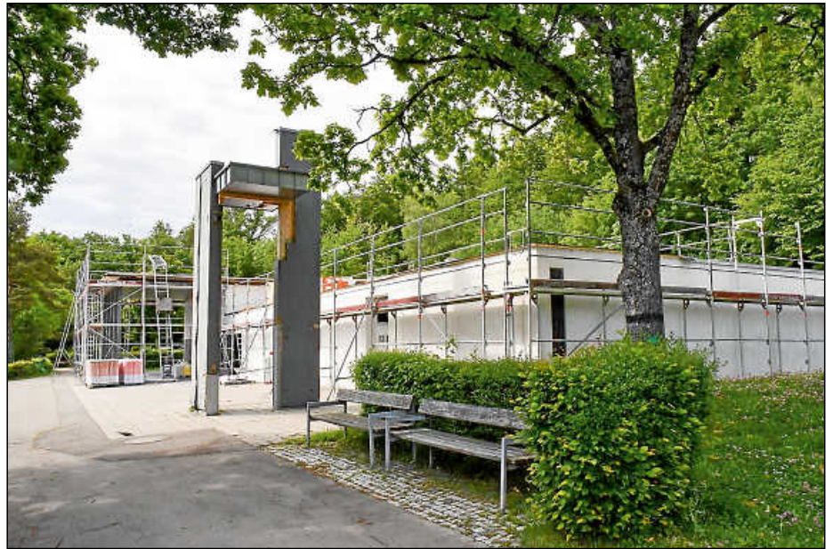
Die Aussegnungshalle des Waldfriedhofs ist eingerüstet, die Bauarbeiten schreiten zügig voran.
