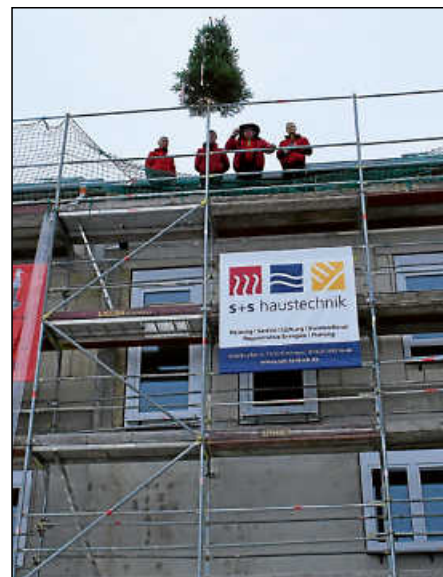
Der Dachstuhl ist errichtet, die Zimmerleute sprechen beim Richtfest auf dem Gebäude-dach den Richtspruch.
