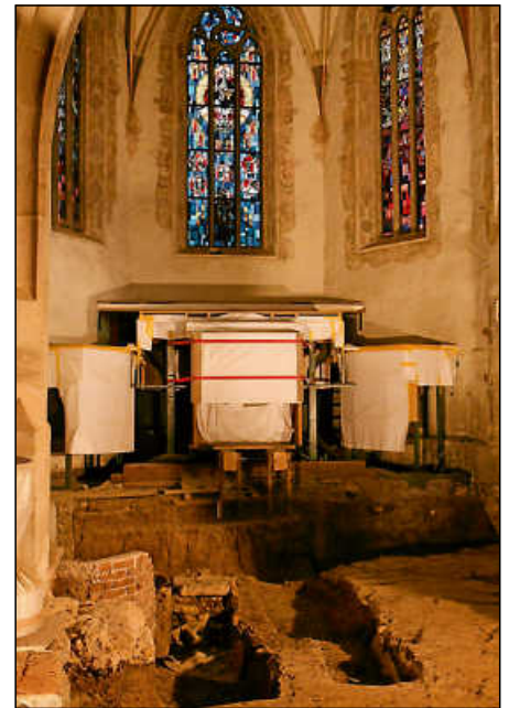
Ausgeräumt und aufgegraben zeigt sich derzeit die Stadtkirche.
