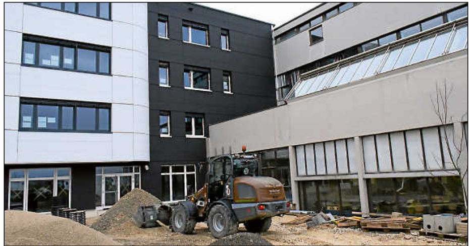
Der Neubau (l.) am Gymnasium ist fast fertiggestellt, die Sanierung des Hauptbaus steht an.
