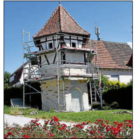
Das Weinbergtürmle in der oberen Wiesbrunnenstraße wird neu gestrichen.
