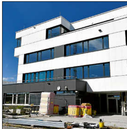
Der Hauptbau des Gymnasiums ist saniert.
