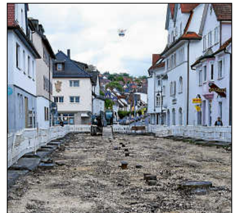
Die Bahnhofstraße ist inzwischen neugestaltet.
