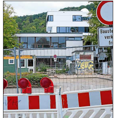
Die Baustelle am Burgplatz rund um den Unterstufenbau des Gymnasiums ist eingerichtet, die Arbeiten können beginnen.
