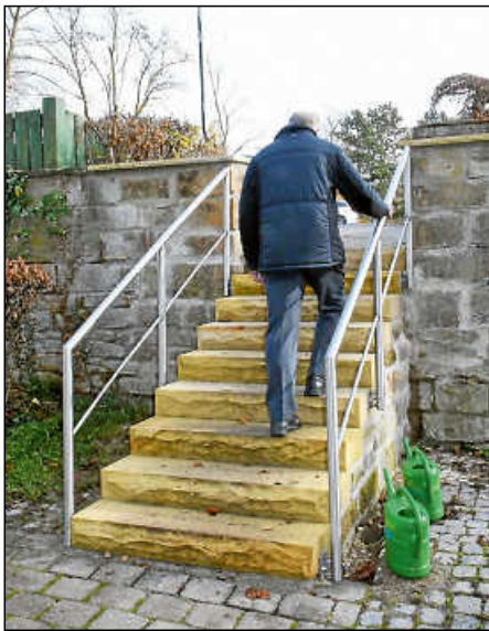
Die Treppe am Stadtfriedhof wurde saniert.
