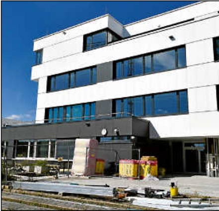
Planungsgemäß wurde die Sanierung des Gymnasium-Hauptbaus fertiggestellt.
