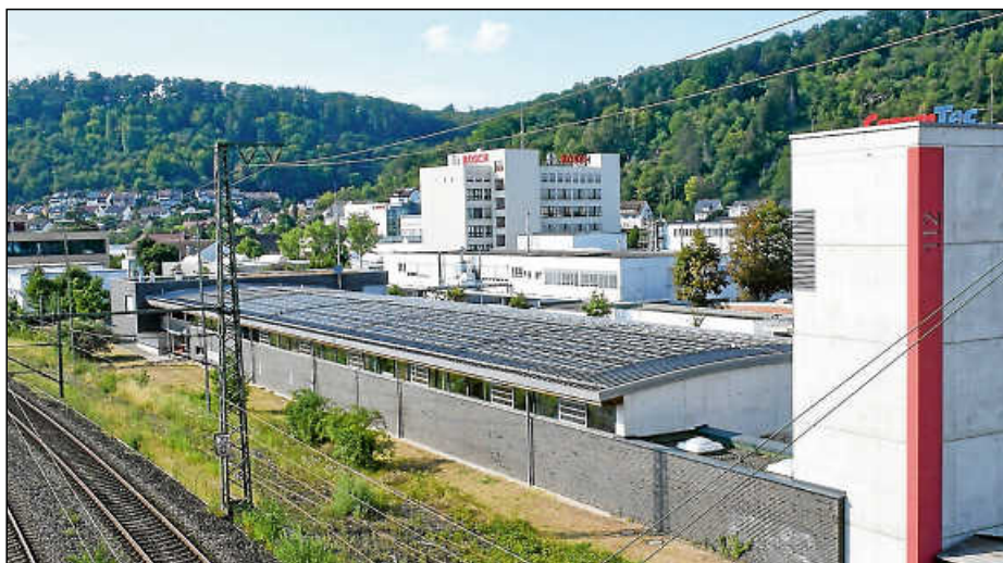
Die PV-Anlage auf dem Dach der Feuerwache soll einmal 145,8 kWp Strom erzeugen.
